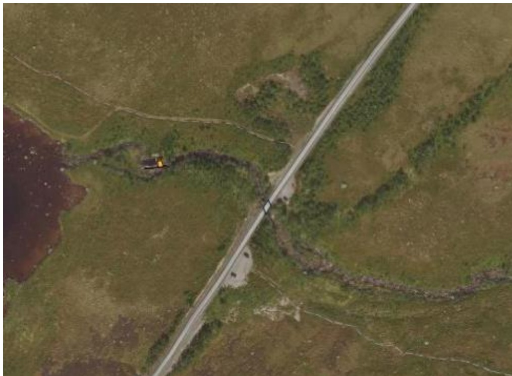
Figur 6. Bildet viser eksisterende vanninntak i Rekvikelva, grustaket som er ønsket ny plassering for vannbehandlingsanlegg og høydebasseng, eksisterende parkeringslommer/utfartsparkeringer og etablerte turstier innenfor det foreløpige planområdet.
